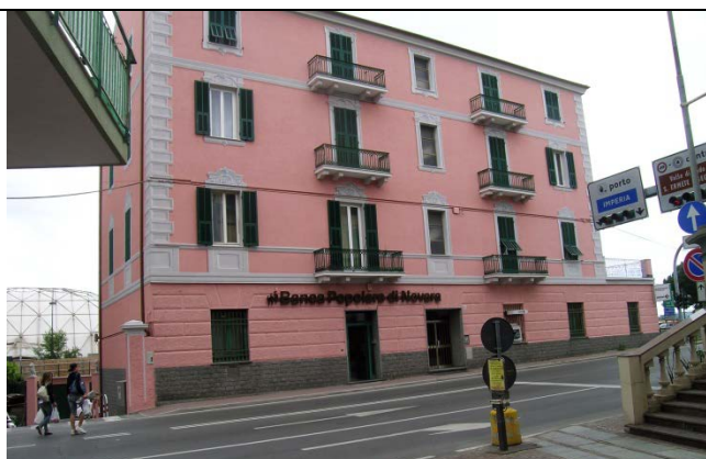
La facciata principale a intervento finito
