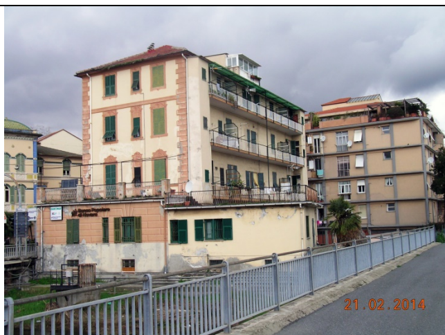
Prospetto laterale prima dell'intervento
