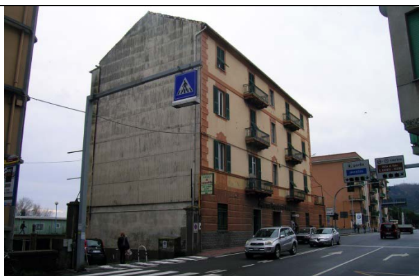
La facciata cieca dell'edificio
